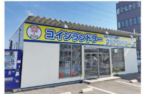
▲クリアランドリー中村町店(本社敷地内)
